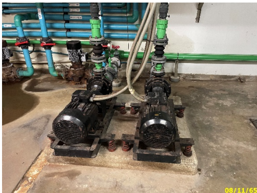
เครื่องสูบน้ำ และถังเก็บน้ำชั้นใต้ดิน
